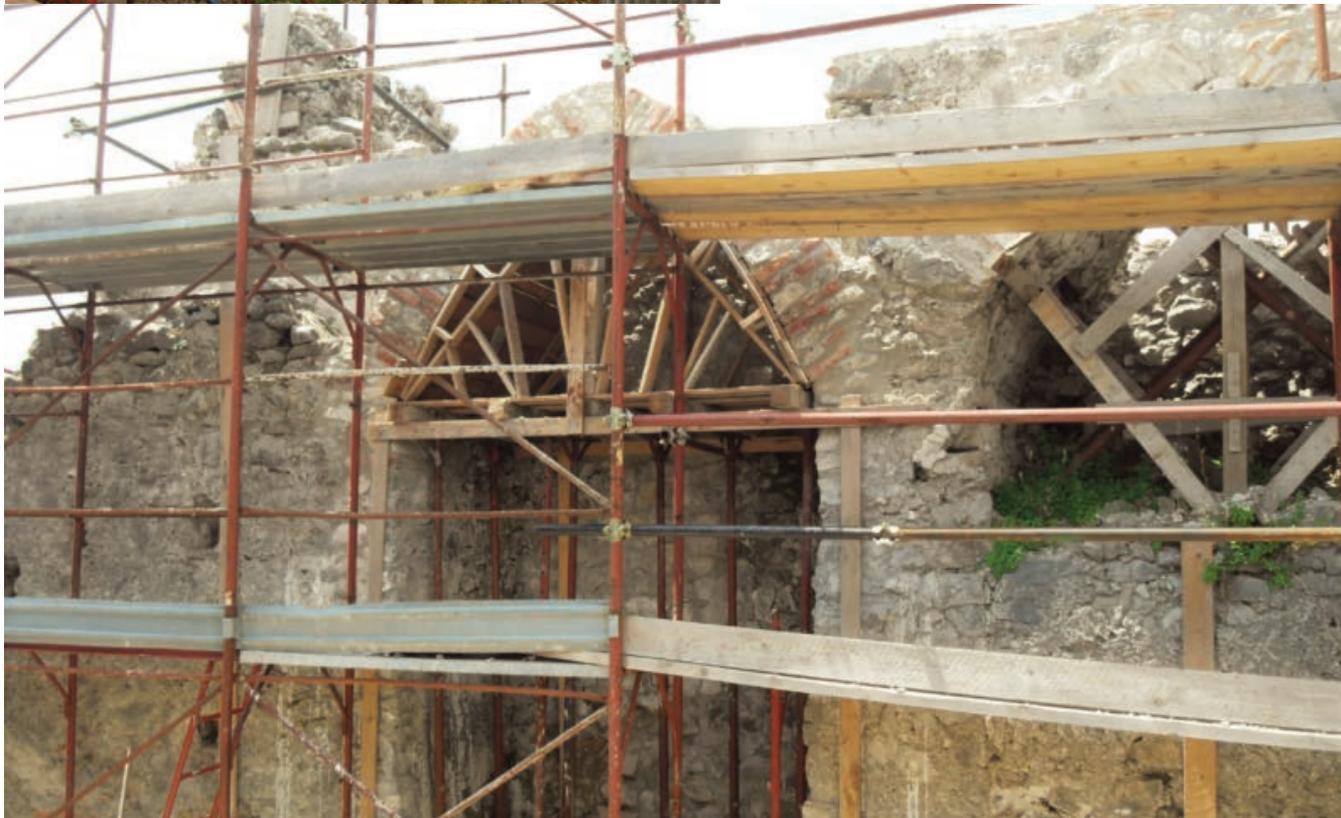
**Corpo C**: è la parte del lato ovest del castello ove sono stati previsti interventi di prevalente ricostruzione con strutture in acciaio e vetro su nuove fondazioni. In tale corpo di fabbrica è superstita solo un brano di pannello murario verso la corte interna oggetto di restauro conservativo. Il livello di calpestio è risultato sottoposto con la emersione di una scala di collegamento.
