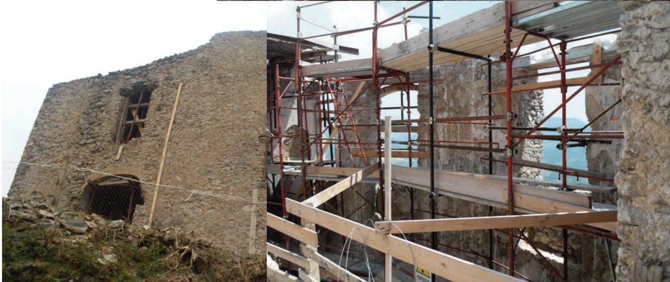
**Corpo B** : ubicato ad ovest; in esso sono previsti interventi di prevalente restauro conservativo, consolidamento statico e ricostruzione. Tale corpo si caratterizza per la testimonianza delle murature del prospetto esterno con le merlature e gli archi superstiti da recuperare.
