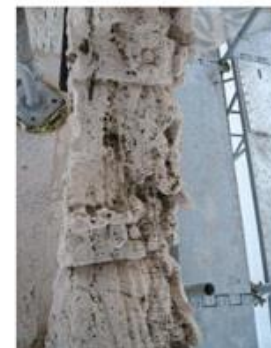
⑦ Particolare del festone (lato sx) In evidenza, l'alveolizzazione del travertino
