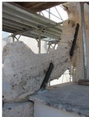
9 Particolare degli ancoraggi del festone (lato posteriore sx)
