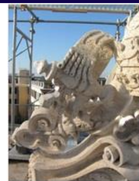
⑤ Particolare dell'elemento scultoreo di coronamento (lato sx)
