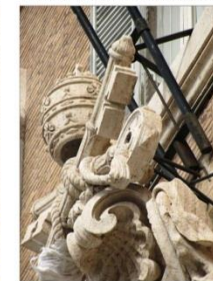
VISTA DAL BASSO DEL LATO SINISTRO
