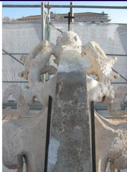
11 Particolare degli ancoraggi dell'elemento murario di sostegno e relativi ancoraggi metallici
