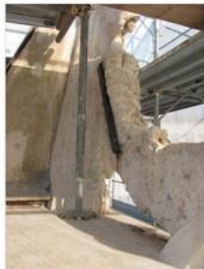
10 Particolare degli ancoraggi del festone (lato posteriore dx)
