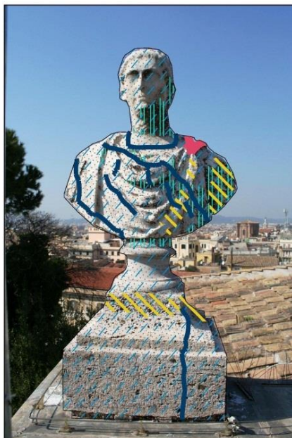
barroto in acciaio inox fissato con implego di malte a base epossidica
