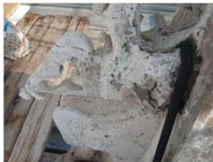
12 Particolare dell'elemento scultoreo raffigurante una chiave (lato posteriore sx) . Nodo di collegamento ancoraggi metallici
