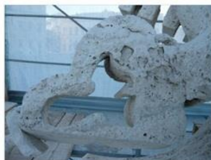
12 Particolari dell'elemento scultoreo raffigurante una chiave (lato p. sx) Si notano i fenomeni di erosione ed alveolizzazione della pietra
