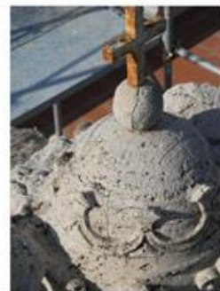
③ Particolare della tiara - In evidenza il dissesto provocato dalla ossidazione dell'elemento metallico
