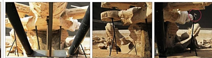
DETTAGLI DEL SISTEMA DI ANCORAGGIO AL MURO DELL'ELEMENTO SCULTOREO MEDIANTE STAFFE
