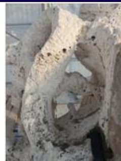
13 Particolare dell'elemento scultoreo raffigurante una chiave (lato p. sx) Si notano i fenomeni di erosione ed alveolizzazione della pietra
